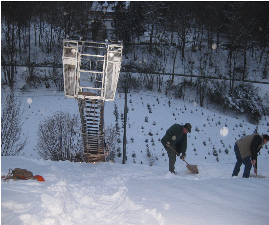
Schneeräumung auf einem 8° Satteldach einer Schützenhalle im Sauerland im Dez.2010 Die Manuelle Schneelastermittlung ergab eine Last von 105 Kg/m 2
